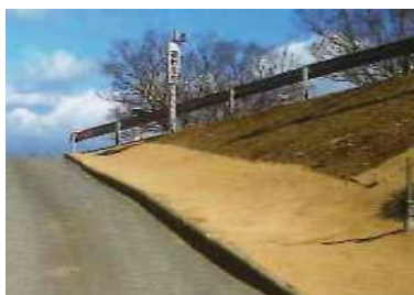
道路路肩の防草
