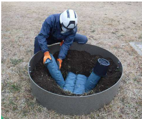
リフレ枠の中に土とくるスト酸素管を設置
