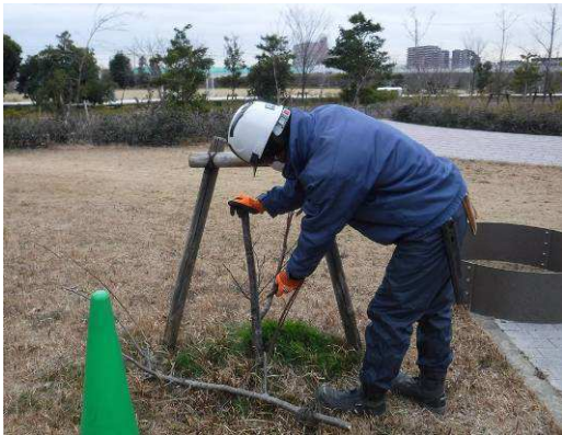
4mmφ H20cm x 径 114cm リフレ枠を設置
