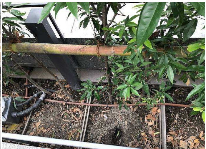
免震リフレフランター設置仕上がり 樹木の根が自在に横に拡がる。
