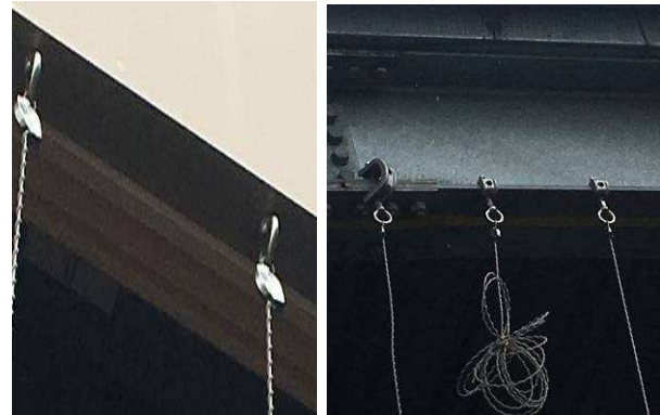
ALCパネルへのアングル取付け H鋼へのワイヤー取付け
