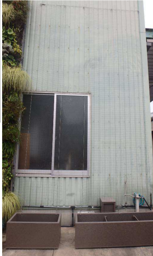
リフトプランターダズルへのワイヤー・ネット緑化
